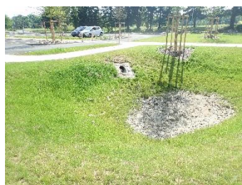
Bassin eaux pluviales (Olivet LNE)
